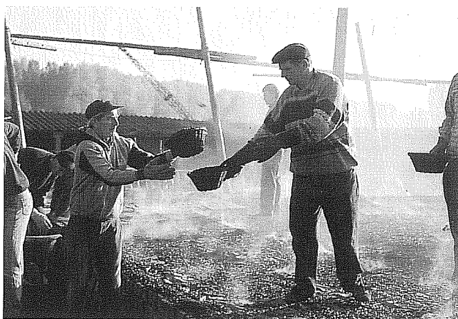
Foto 6: ■ Tussen iedere laag stenen een laag antraciet.
