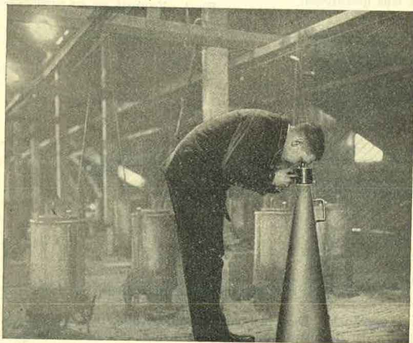
Fig. 5. Temperatuurmeting met den Pyrheo op een vlamoven.
