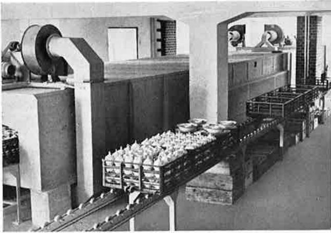
Abb. 4. Tunnelofen mit Rollenrücklaufbahn.
