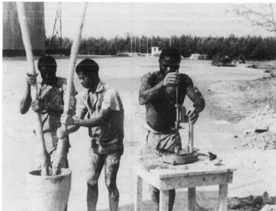
Figuur 3: consistentiecontrole met het pfefferkornapparaat bij de vervaardiging van handvormstenen.
