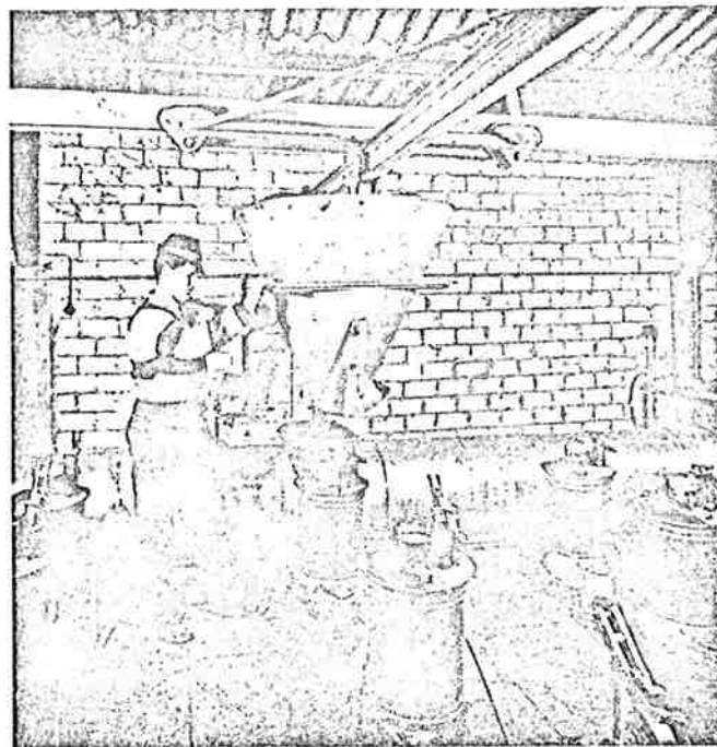
Afb. 6-30 : Het vullen van de kolenstookapparaten met een vultrechter aan een takelbaan.
