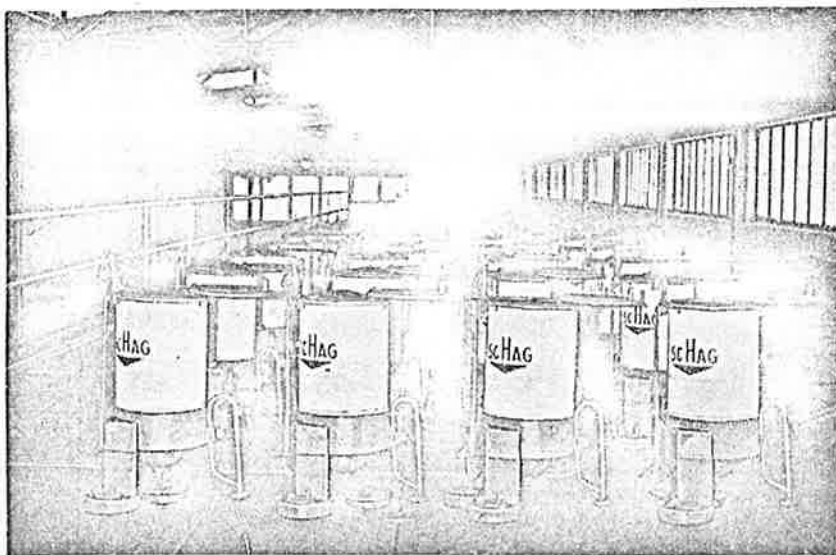
Afb. 6-24 : De opstelling van Schag-stookapparaten met electrohydraulische aandrijving.
