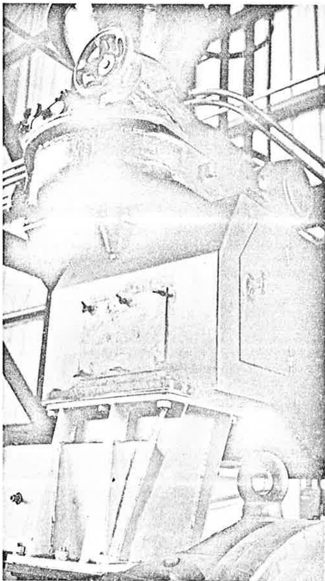
Afb. 6-102 : De scho- telvoeder boven op de maalinstallatie.
