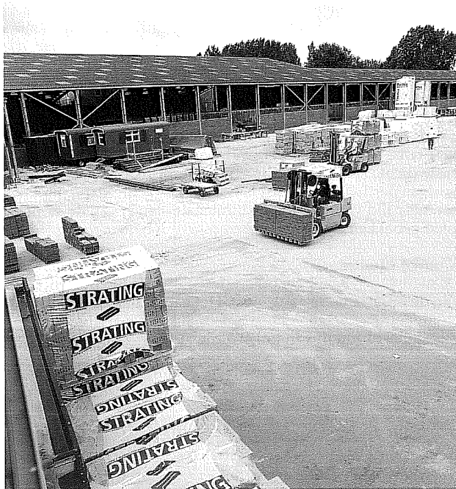
Figuur 2: ■ Productiehal met bovengestookte tunneloven in aanbouw.
